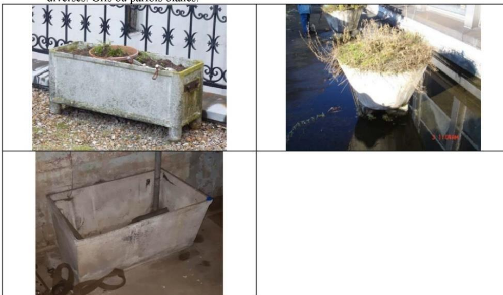
- Bacs à fleurs (jardinières), évier, réservoirs. Bacs en amiante-ciment assez fins de formes diverses. Gris ou parfois blancs.
